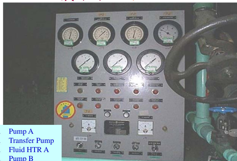
BPV HPU儀錶架照片
